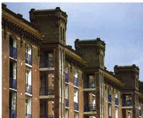
Pakhuizen in het Amsterdamse oostelijke havengebied omgevormd tot wooncomplexen
