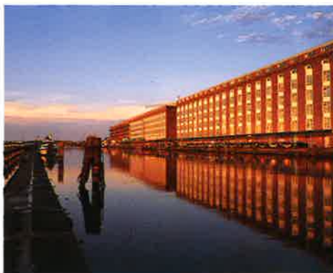
De voegen zijn eruit geslepen en opnieuw gevoegd, resulterend in bijna 100 km nieuw voegwerk
