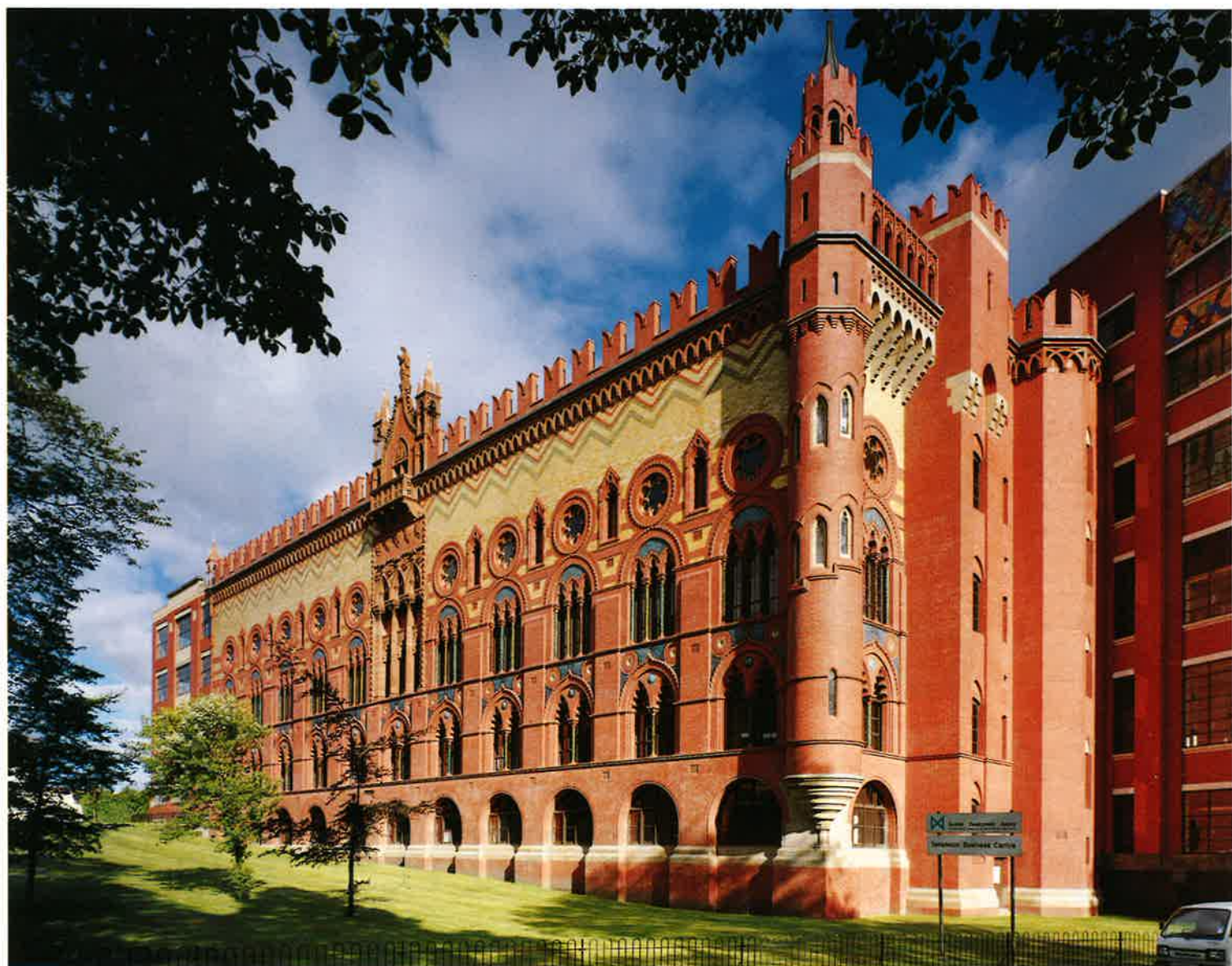
Het Templeton Business Centre kreeg in 1985 de Supreme Award voor de SDA/RIAS Regeneration of Scotland Design Awards. De voormalige Templeton Factory in Glasgow, waar tapijten werden geweeft, werd gerenoveerd en omgevormd tot een centrum voor beginnende ondernemers door Jim Anderson van Anderson Bayne Architects uit Glasgow. Het hier afgebeelde 'Dog's Palace' werd in 1898 ontworpen en gebouwd
